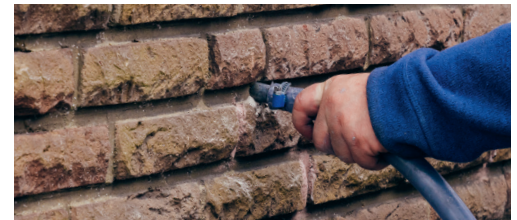
Aminotop++ wird eingebracht.
