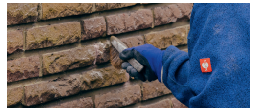
Fachgerechtes Verschließen der Bohrlöcher.
