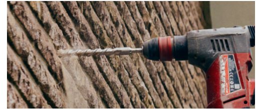
Präzises Bohren der Löcher zur Vorbereitung.
